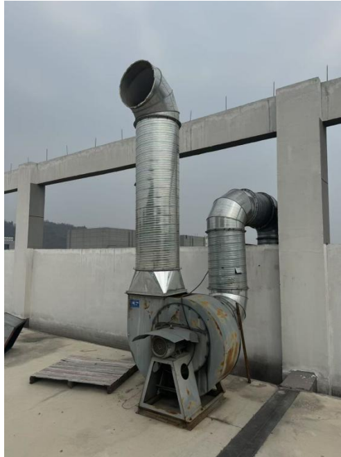
图 3-3 试机废气排放设施
